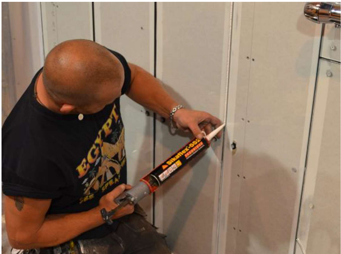
Bild 12. Fogning mellan glaspaneler.
