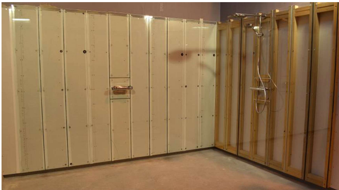
Bild 3. Glaspanelerna på vägg 1 och 2 färdigmonterade.
