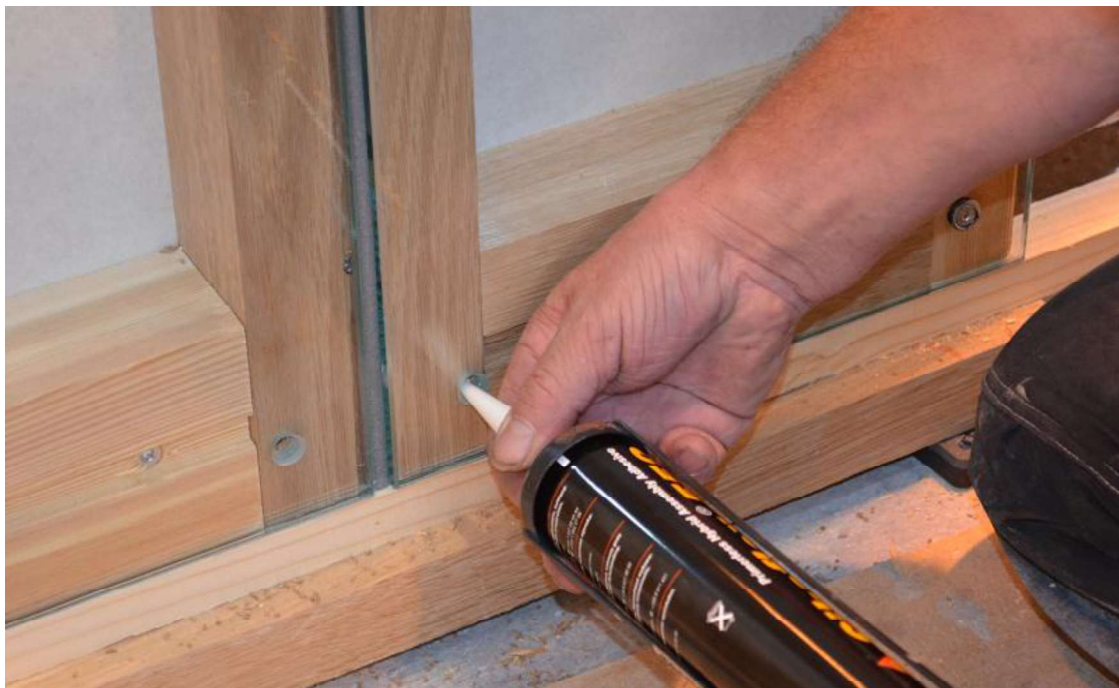
Bild 7. Infästningshål fylls med fogmassa.
