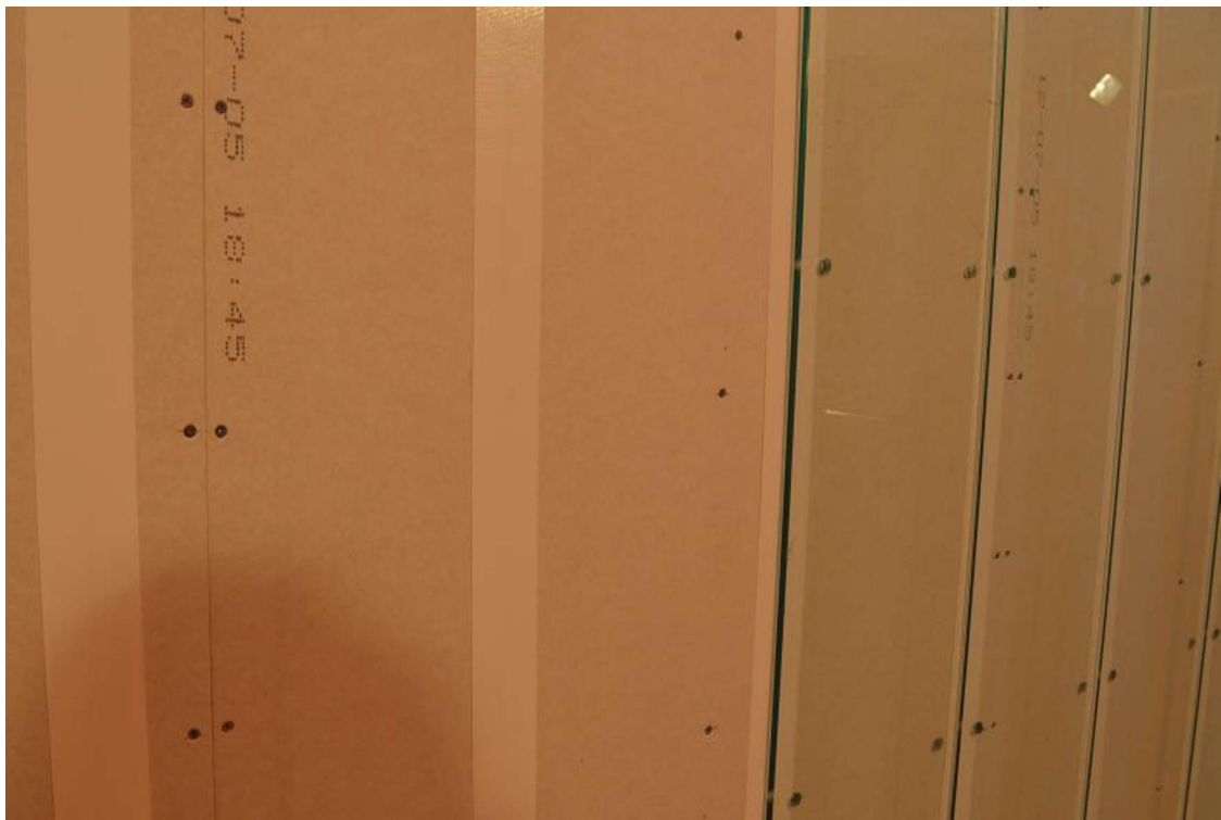
Bild 9. Väg 1 under montering.
