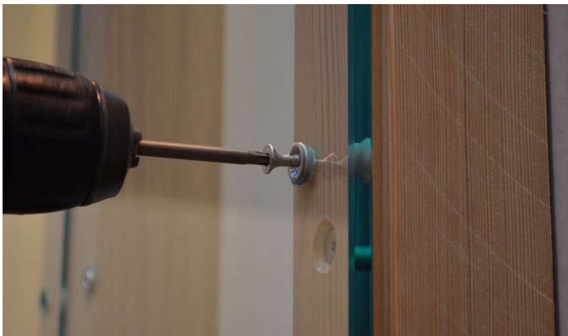
Bild 8. Skruv och plasthylsa monteras.
