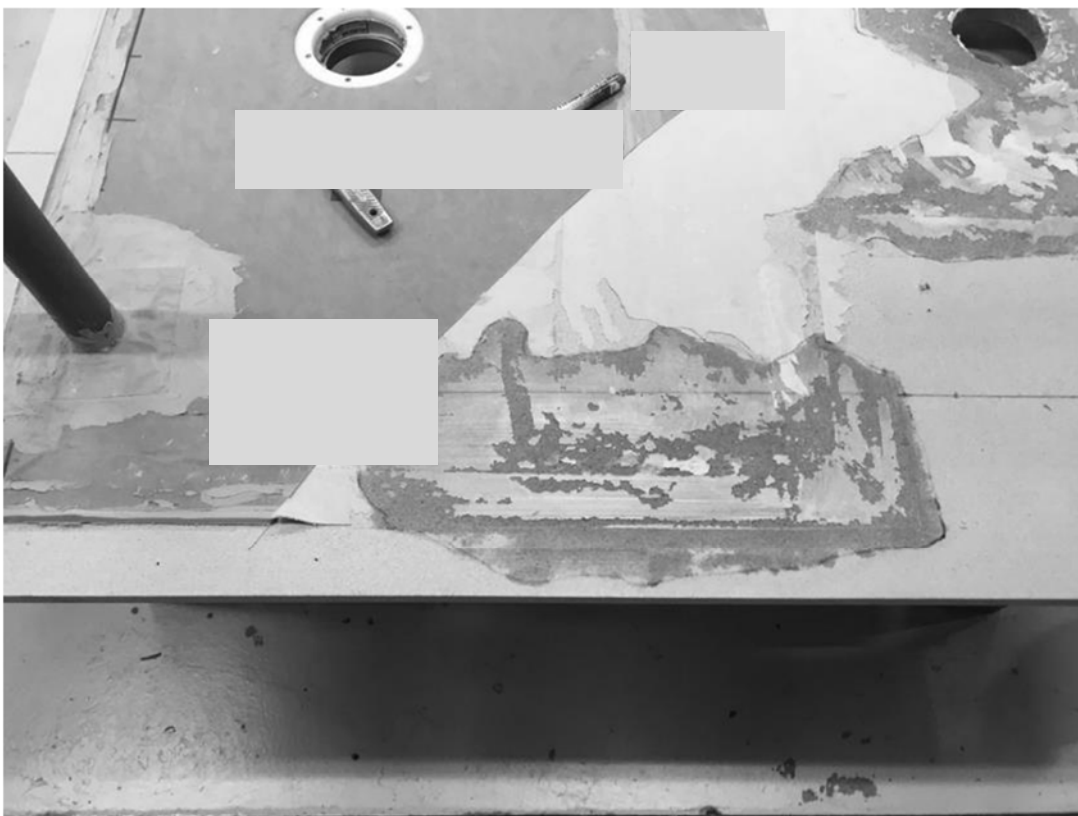
Bild 13. Punkt 6, 7 och 8: Sammanhängande större läckage vid innerhörn, storlek ca 50x20 cm.
