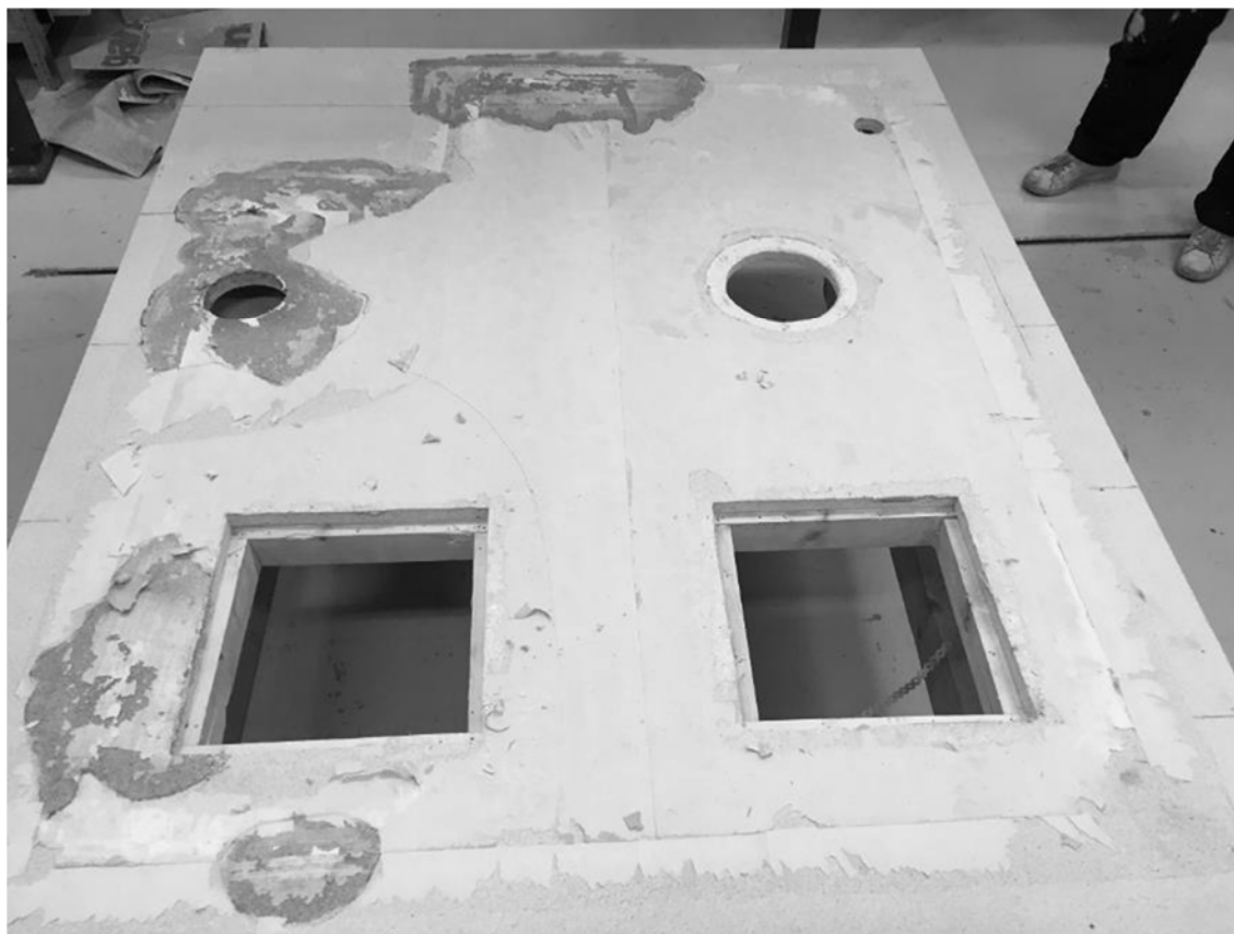
Bild 11. Överblick över hela golvytan.
