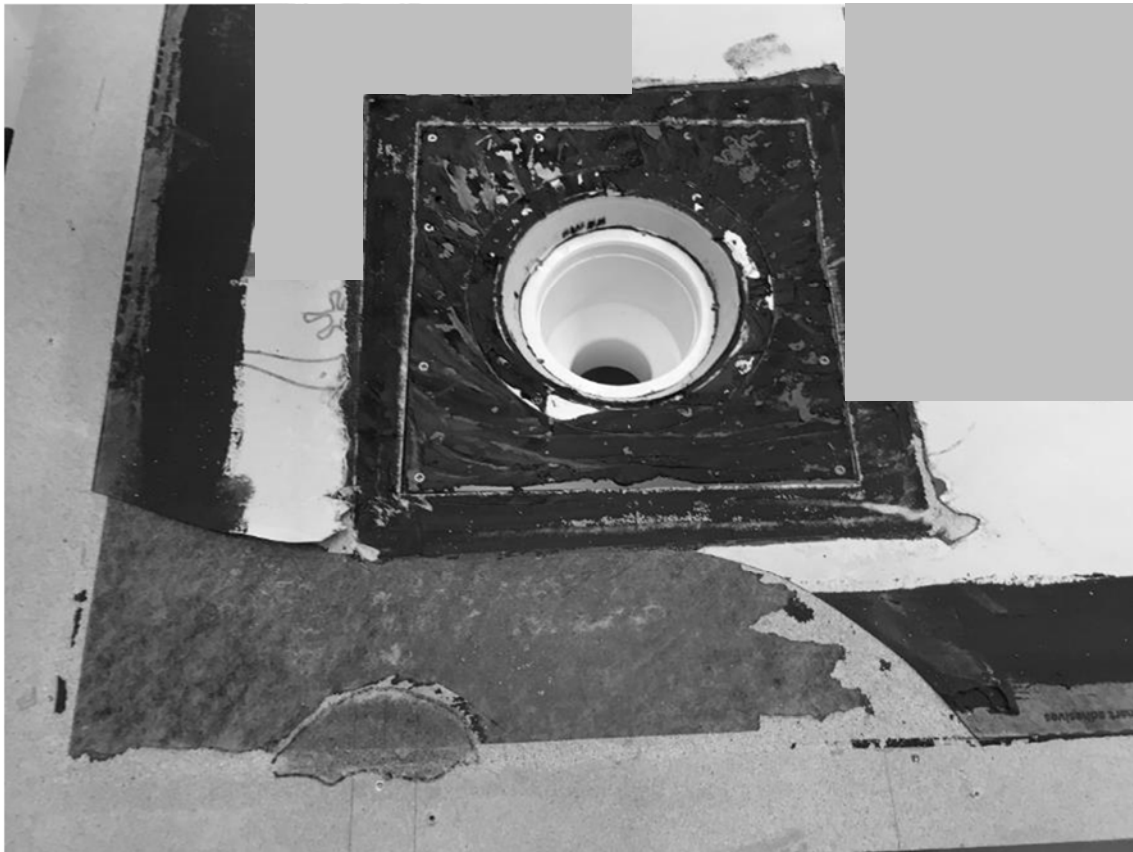
Bild 2. Punkt 11. Mindre läckage vid innerhörn. Storlek ca 5 x 10 cm.
