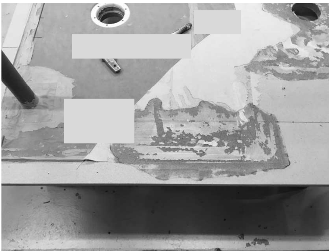
Bild 13. Punkt 6, 7 och 8: Sammanhängande större läckage vid innerhörn, storlek ca 50x20 cm.
