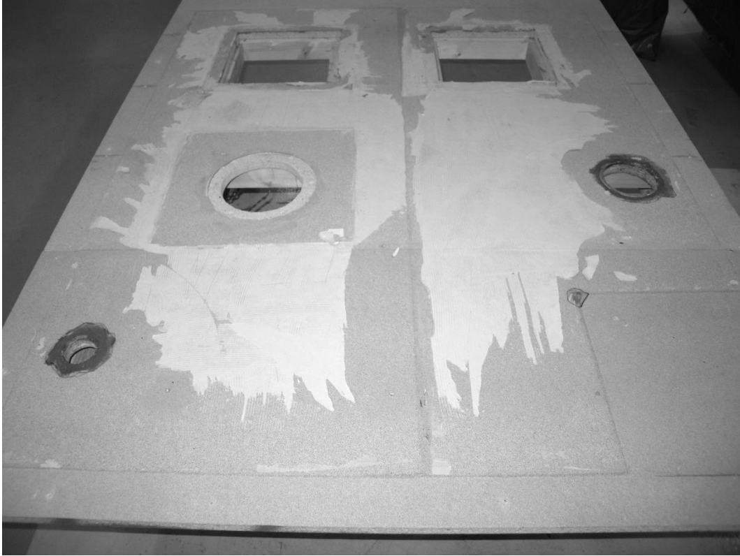
Bild 29. Läckage vid stort och litet avloppsrör samt vid ytterhörn.
