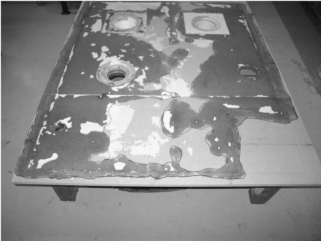
Bild 3. Blöta partier på golvet efter rivning.
