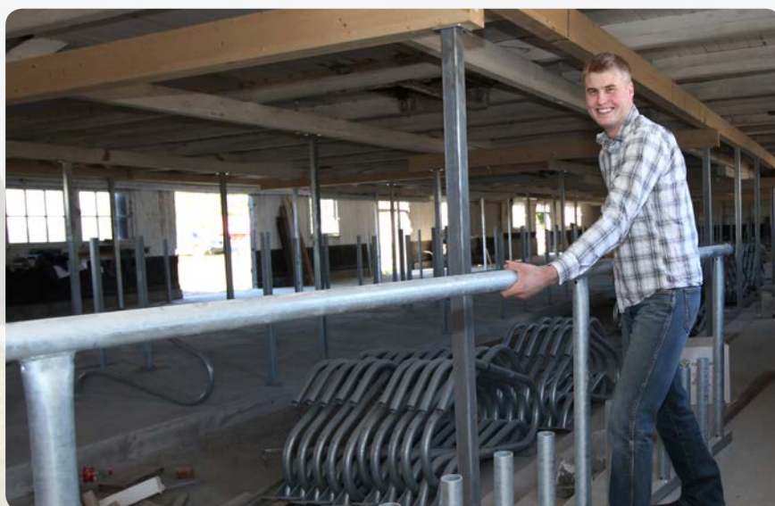
Kristofer bygger om den gamla ladugården för modern lösdrift av ungdjur.
